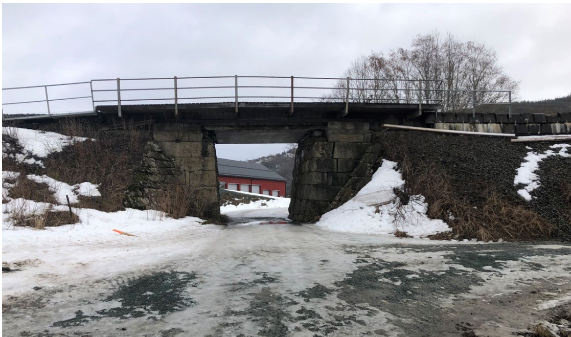
Figur 11: Dagens undergang under jernbanen ved Loddbekken. Del av driftsbygning i tunet på gnr./ bnr. 91/1 er avbildet.
